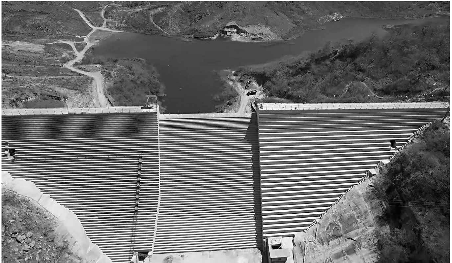
A Barragem Nova Camará foi reconstruída pelo Governo do Estado e vai levar água para municípios e comunidades atingidas pela tragédia ocorrida em 2004
